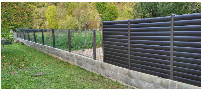
Clôture grillagée sur muret avec palissade
