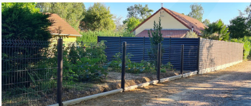
Clôture grillagée avec embase ciment
