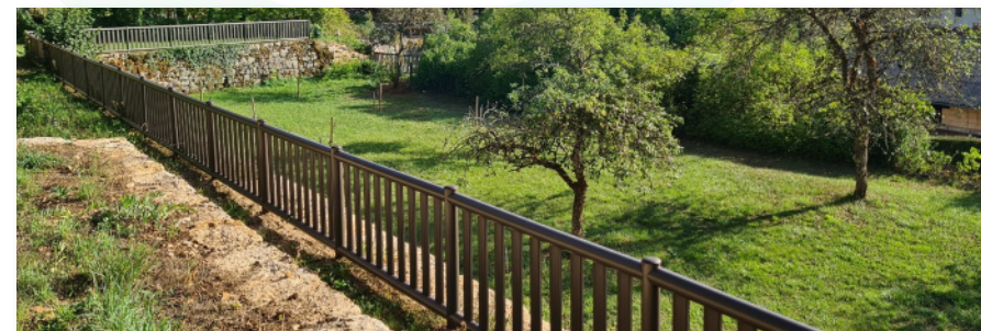
Barrière de sécurisation de belvédère
