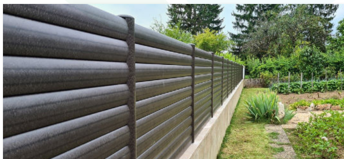
Palissade sur muret
