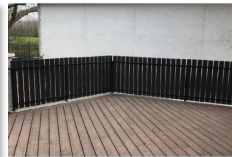
Barrière de terrasse sécurisée
