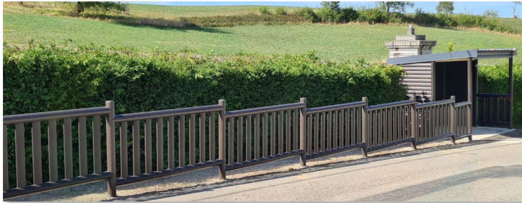
Abribus avec barrière de sécurisation
