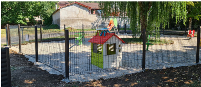
Clôture de sécurisation aire de jeux
