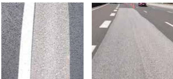
Le Coefficient de Frottement Transversal (domaine autoroutier) et le Coefficient Frottement Longitudinal (domaine aéroportuaire et autoroutier) sont les deux coefficients de références sur la chaussée en France. Lorsque le support perd de l'adhérence due à l'action mécanique des pneumatiques et de la pollution hydrocarbure, le grenailage permet de la régénérer en faisant ressortir la micro et la macro texture des granulats.
