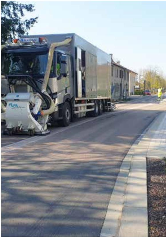
Notre atelier fonctionne en circuit fermé à l'aide d'un système d'aspiration mobile, puissant, équipé de 24 filtres et d'une mise en Big Bag automatique des déchets à traiter. Pour optimiser le ramassage des billes d'acier, ces camions sont équipés d'un tapis magnétique ce qui permet de rendre un support propre, adhérent et sans résidu ferreux.
